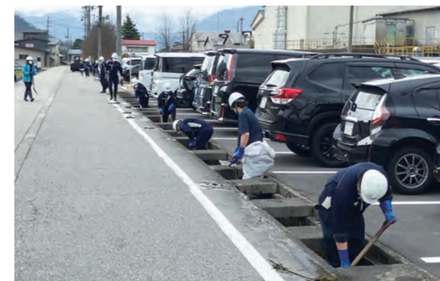
【本社工場周辺側溝の清掃】
